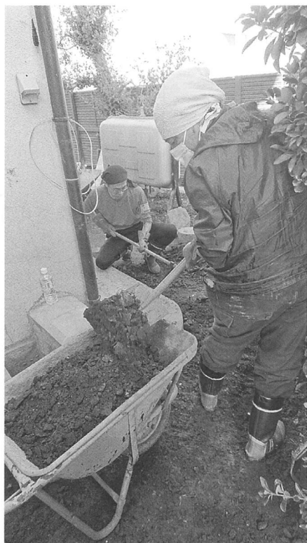
敷地内の泥出し
